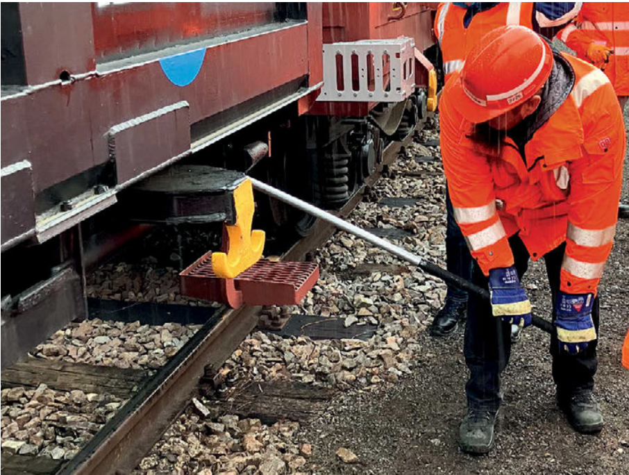
Abb. 2: Erprobung einer manuellen Bedieneinrichtung im Ablaufbetrieb
